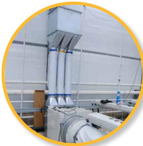
STERITUBE Basic Luchttechnische installatie in tomatenkas
