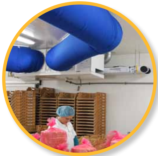
STERITUBE Basic Airsock en koel applicatie
